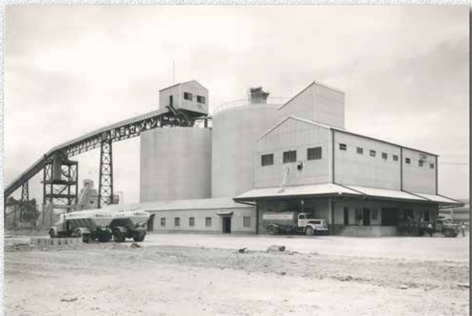
堺 S・S セメントサイロ 5000t 2 基
