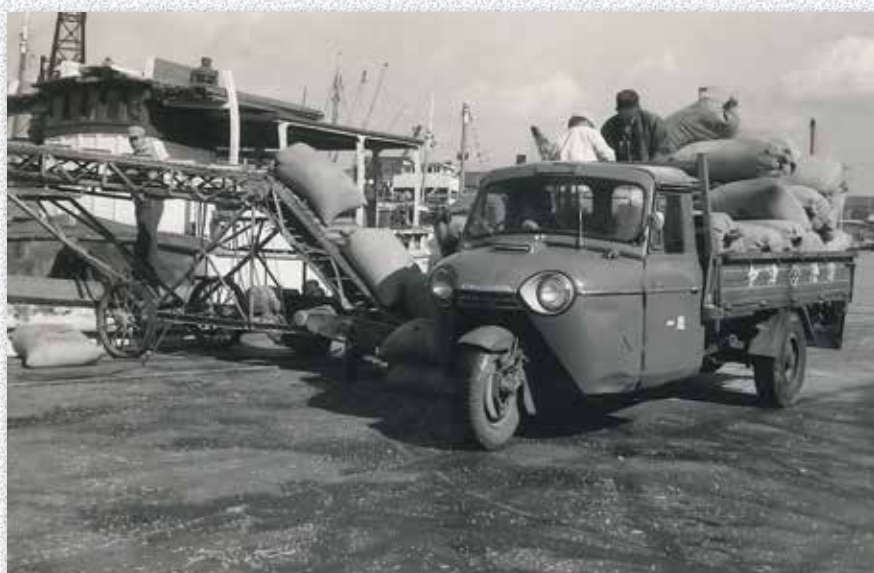
三輪車用パイラーにて積み下ろし
